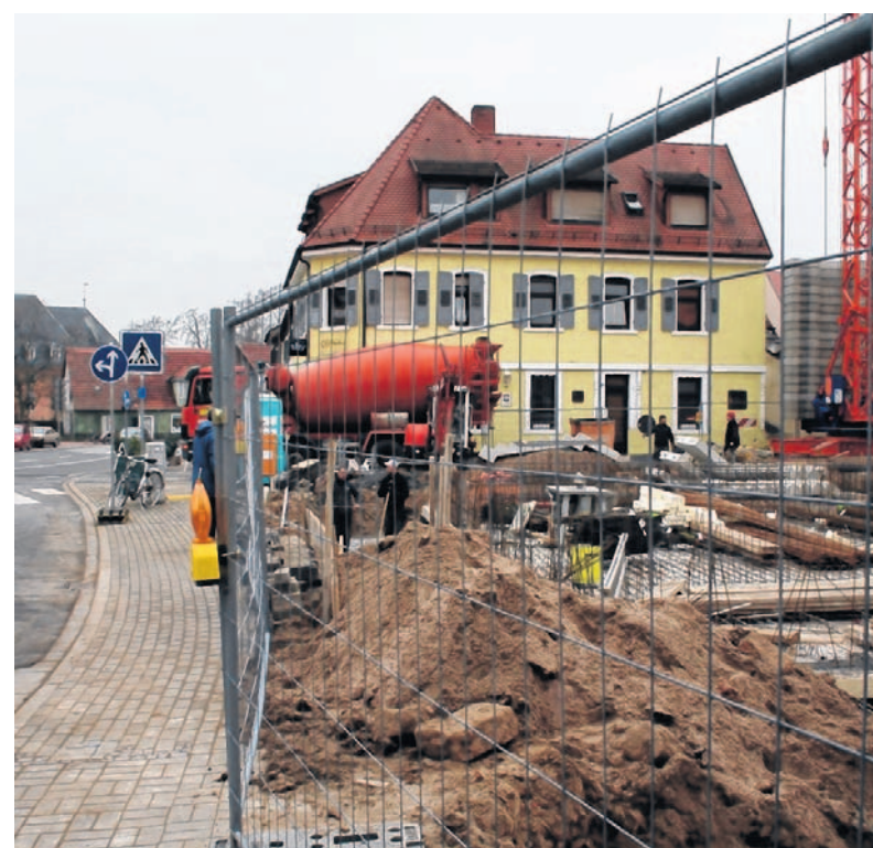
Vis-à-vis vom Café Montreux entsteht ein neues Wohn- und Bürohaus.
